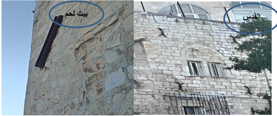
الشكل 4: مشابك حديدية لمبانٍ تاريخية في مدينة القدس ومدينة بيت لحم متأثرة بزلزال عام 1927م. المصدر: تصوير الباحث 2023-12-21.
